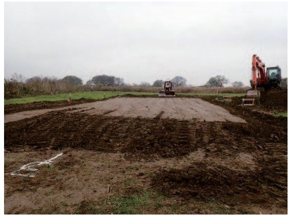
写真6 2層目転圧後の状況
