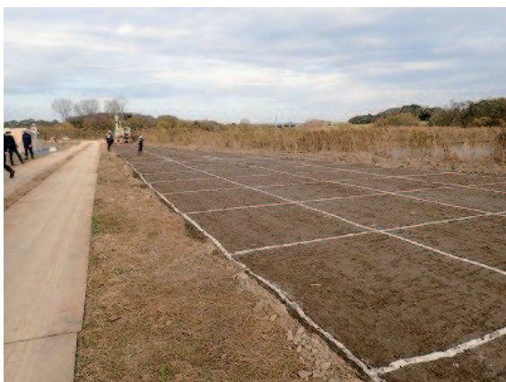
写真1 改良前の状況
