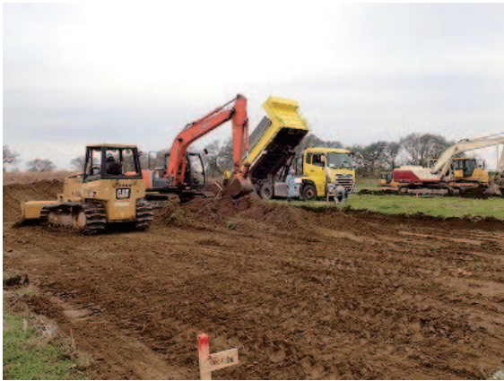
写真5 まき出し、転圧の状況
